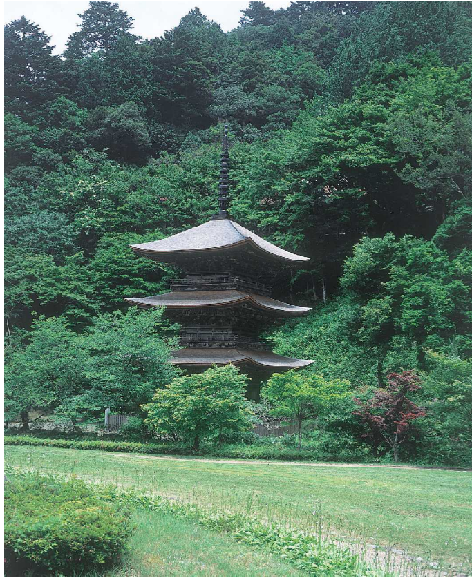
京都府舞鶴市 金剛院 重文 塔婆 (三重塔)
